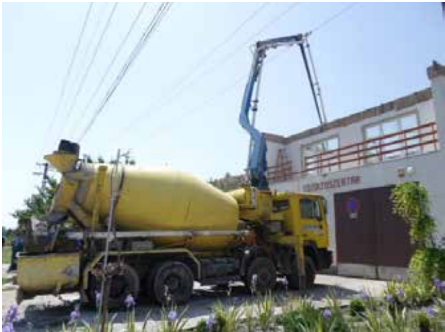
7.-8. kép. betonpumpa gémje a villamos felsővezeték közvetlen közelében (munkavédelmi hatóság felvétele)
